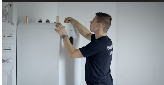
Færdigt arbejde uden tunge løft
